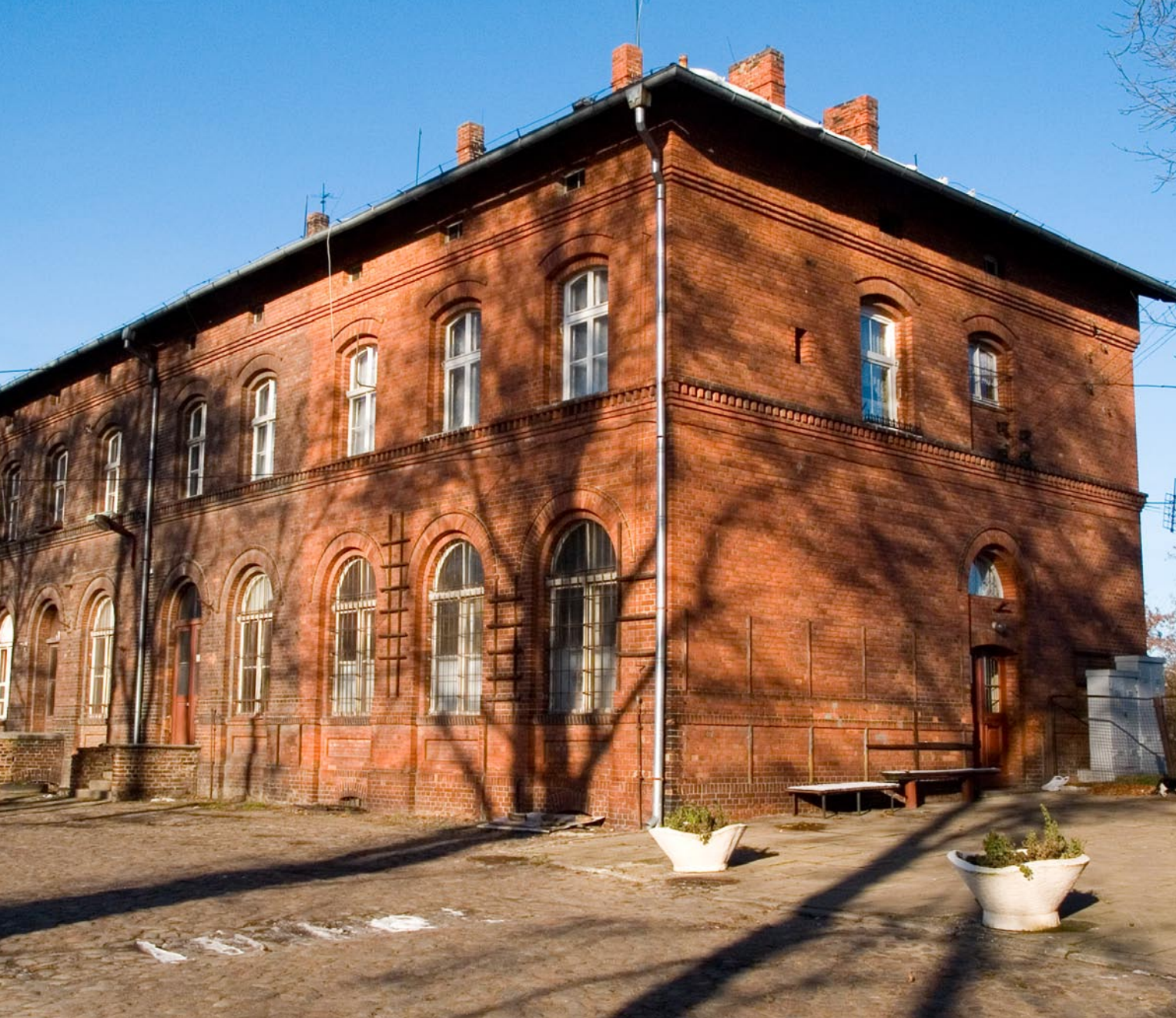
budynek starego dworca w Kwilczu zaadaptowany na potrzeby CIS Chudobczyce
